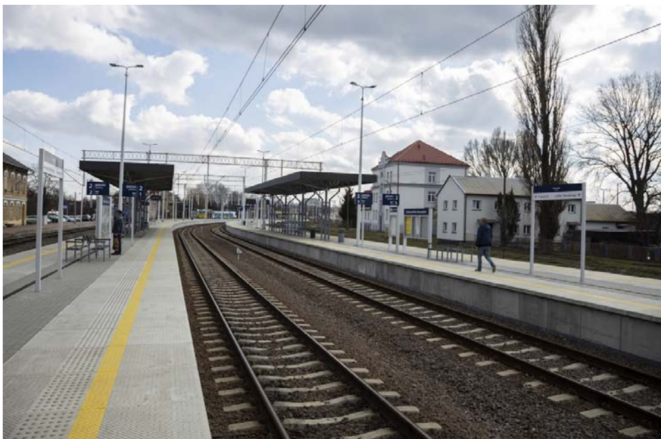
Stacja Stalowa Wola Rozwadów
